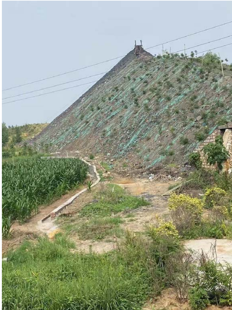
排水沟、挡渣墙、绿化
