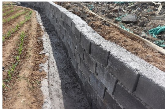
挡渣墙和排水沟
