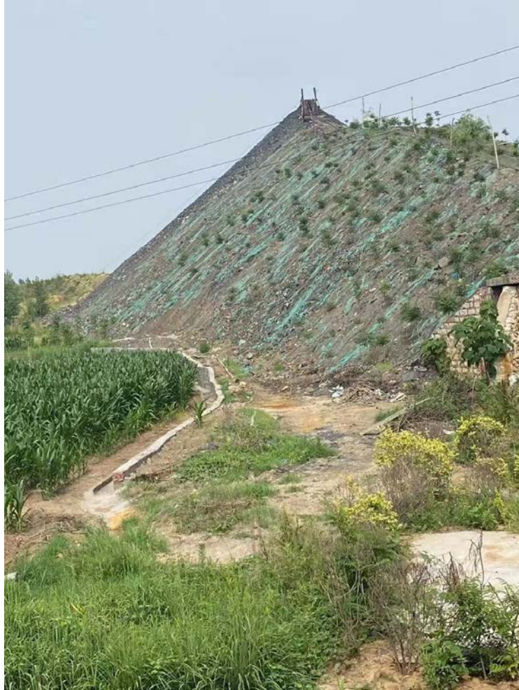
挡渣墙和排水沟
