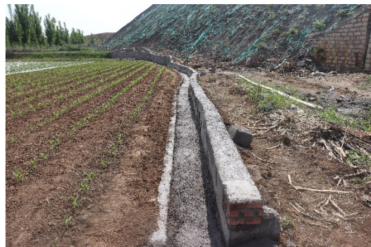
浆砌石排水沟
