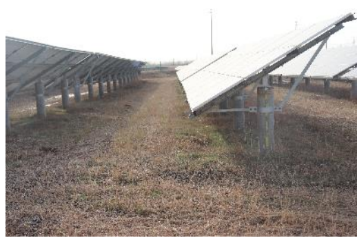
光伏板区碎石防冲带
