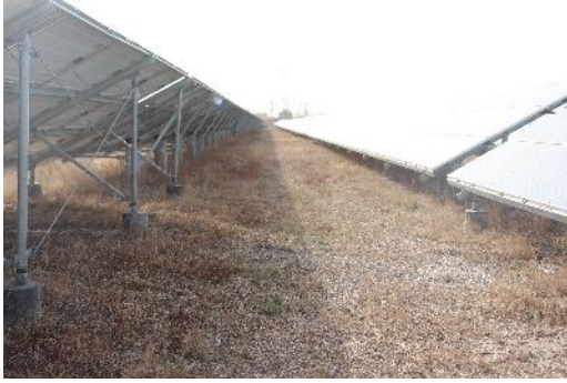
光伏板区碎石防冲带
