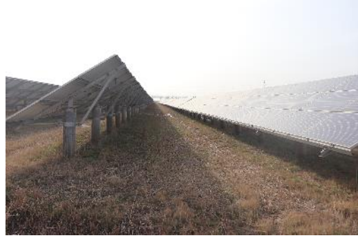
光伏板区碎石防冲带
