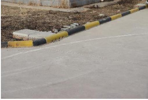
开关站区排雨水工程
