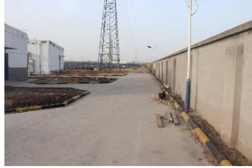
开关站区混凝土道路
