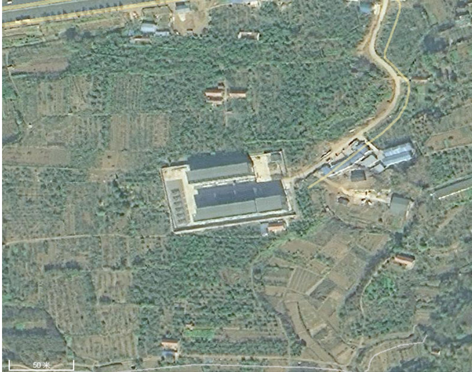
变电站---2014 年（施工后）
