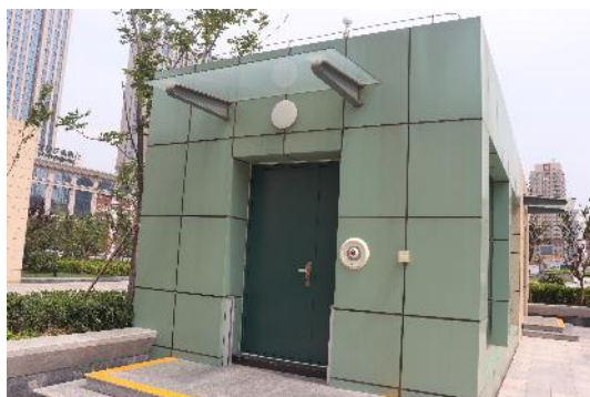
建昌变电站地上部分
