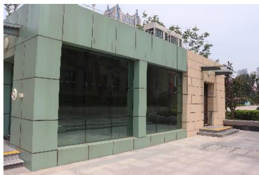
建昌变电站地上部分
